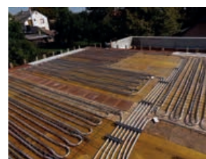
Készre szerelt SLAB-16 rendszer területátadásra kész állapotban.
