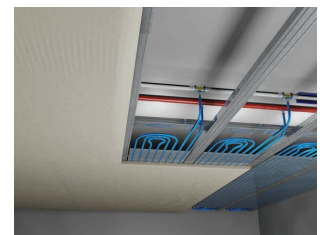
27. ábra Az elkészült fűtő-hűtő álmennyezet elburkolása
