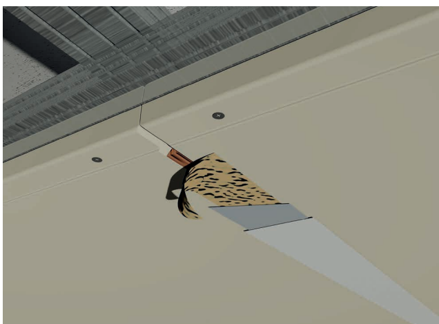
Kereszt irányú rések glettelése
