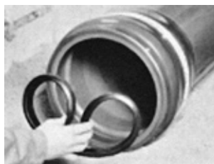
77. ábra: Tokos csőkötés elkészítésének főbb munkafázisai:
