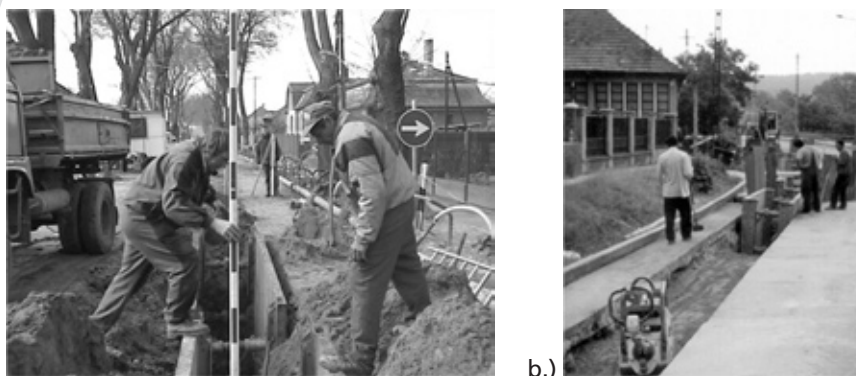
83. ábra: Folyamatos építés nagytáblás dúcolással a.) csőszerelés dúcolat védelme alatt, b.) szalagszerű építésszervezés nagytáblás dúcolattal
